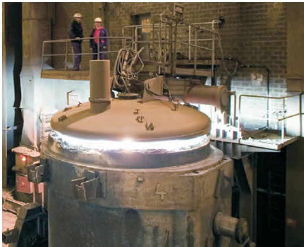
Рис.15. Разогрев 60-тонного ковша газокислородной горелкой на заводе Ovako, Hofors Works.
