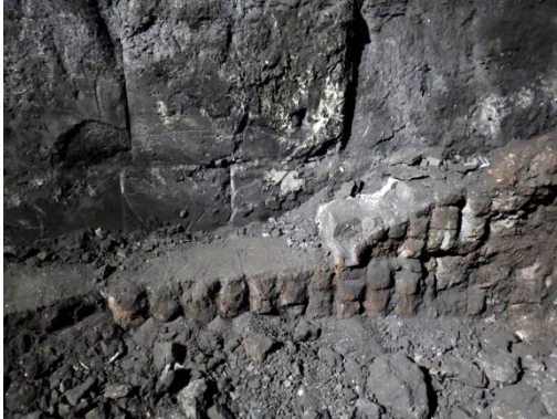
Рисунок 2 – Фотокадр залишків керамічного стакану «Saint-Gobain» на рівні 8-го ряду вуглецевих блоків ДП №8 ПАТ «Арселор Міттал Кривий Ріг».
