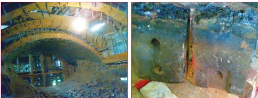
Рисунок 2 – Зображення склепіння двованного сталеплавильного агрегату в процесі демонтажу (а), руйнування цегли (б) через інфільтрацію шлаку та виникнення сколювання [2].
