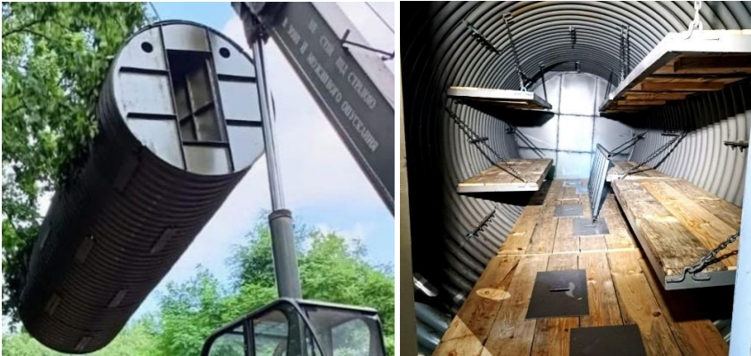
Рисунок 1 – Металева капсула при встановленні краном та її внутрішній інтер'єр.
