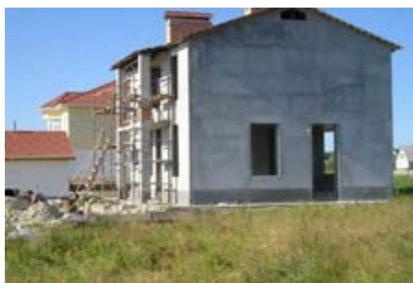
Рис. 1 - Жилой двухэтажный дом, возводимый с использованием стеновых газобетонных панелей
