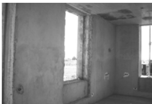
Рис 2 - Фрагмент внутреннего помещения жилого двухэтажного дома, возводимого с использованием стеновых газобетонных панелей
