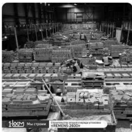
Рис. 2. Огнеупорная кладка коксовой батареи
