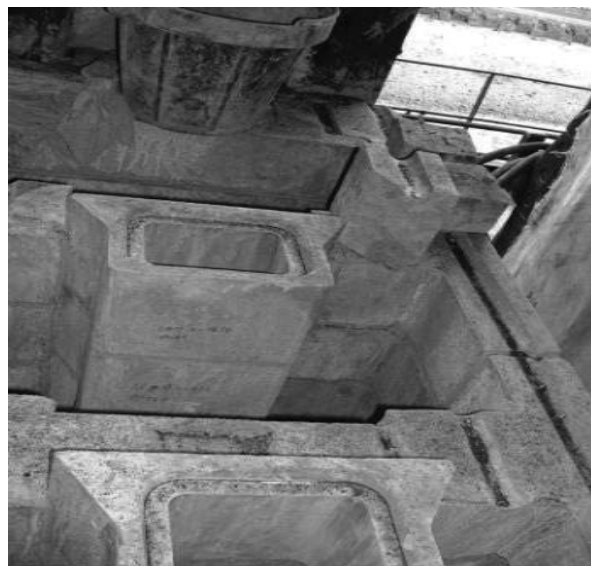
Рис. 7. Литые блоки в кладке отопляемого простенка коксовой батареи
