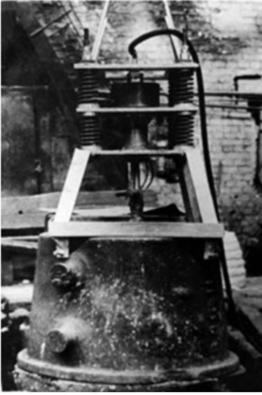
Рис. 1. Загальний вигляд установки для вібраційної ендогенної обробки розплаву.
