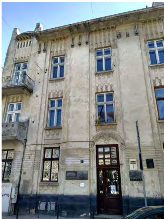
Рис. 4. Будинок на вул. Т. Романовича, 1 (зараз – Саксаганського, 1) у Львові у якому знаходився склад фірми Сколімовського–Сулімівського Fig. 4. Building on T. Romanovych st., 1 (now – Saksaganskyi, 1) in Lviv, where warehouse of Skolimowski-Sulimirski's firm was situated
