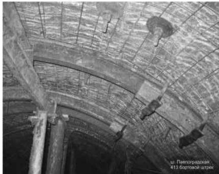
Стан гірських порід в 50 м. за лінією очисного вибою лави (ш. Павлоградська ВАТ «Павлоградвугілля»)
