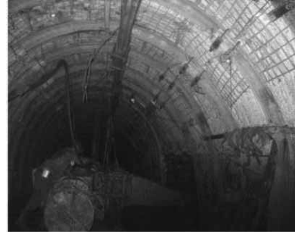
Стан 536 збирного штреку (ш. Тернівська ВАТ «Павлоградвугілля») на лінії очисного вибою лави
