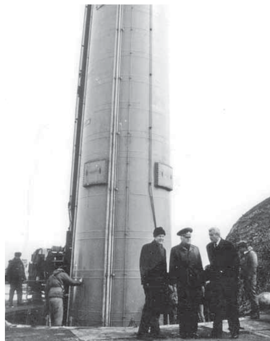
Рис. 10. Извлечение ракеты из шахтной пусковой установки
