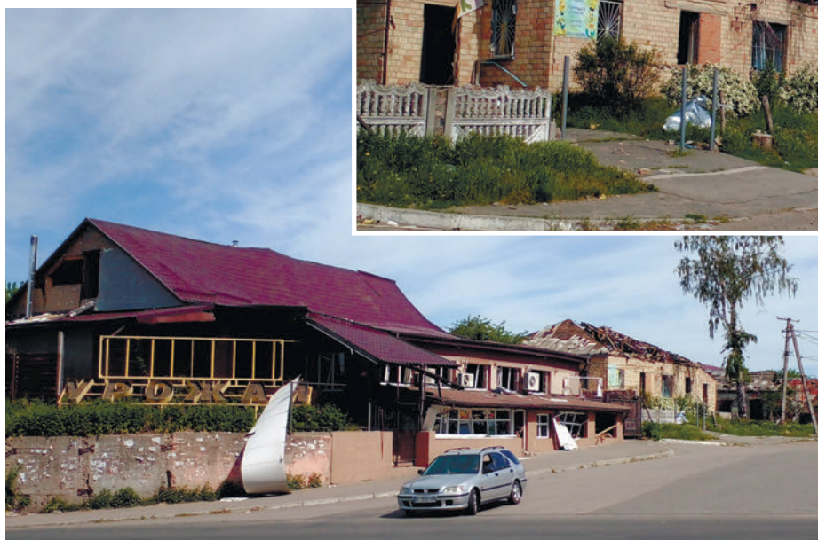
Руйнування центру села Бишів Фастівського р-ну Київської обл. Березень 2022 р. Світлина Л. Пономар
