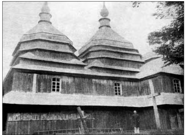
Волосянська церква після ремонту. Світлина В. Щербаківського. 1909 р.
