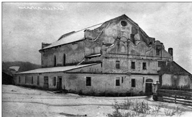
Іл. 7. Ізяслав. Синагога. XVII—XVIII ст. Вид на західний та північний фасади. Фото П. Жолтовського. 1929 р. (ІР НБУВ. — Ф. 278. — С. 499. — Од. зб. 112). На фронтоні головного фасаду можна бачити сліди напису на івриті, яку часто розміщували перед входом в синагогу «Яке страшне оце місце! Це не що інше, як дім Божий, и це брама небесна» (Буття 28:17)
