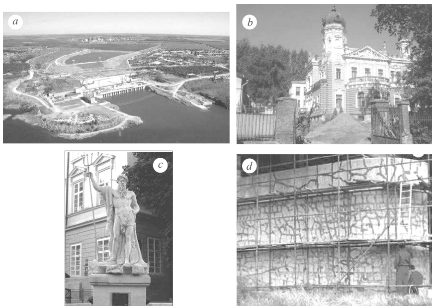
Рис. 8. Тривалоексплуатовані масштабні будівельні (а) та культурно-історичні (b–d) об’єкти, відновлені ін’єктуванням.
