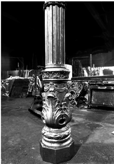
Рис. 2. Чавунна декоративна частина колони і деталь, вилита за друкованою моделлю
