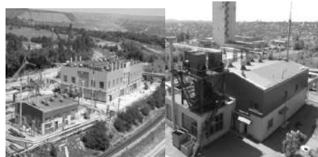
Найпотужніший в Європі когенераційний енергокомплекс на шахті ім. Засядька
