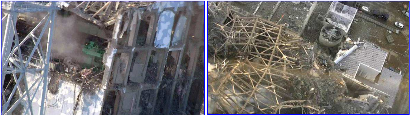
Рис. 3. Фото разрушений на АЭС Фукусима-1.
