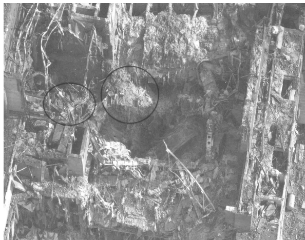
Рис. 2. Завали ЦЗ 4-го блока ЧАЕС (вид зверху).
