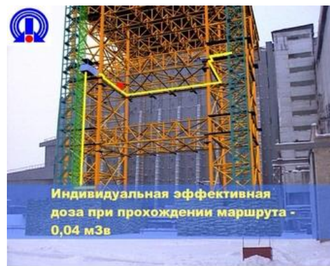
Рис. 4. Інтеграція фото об'єкта "Укриття" і моделі конструкції посилення об'єкта з маршрутом доступу і дозою на маршруті.
