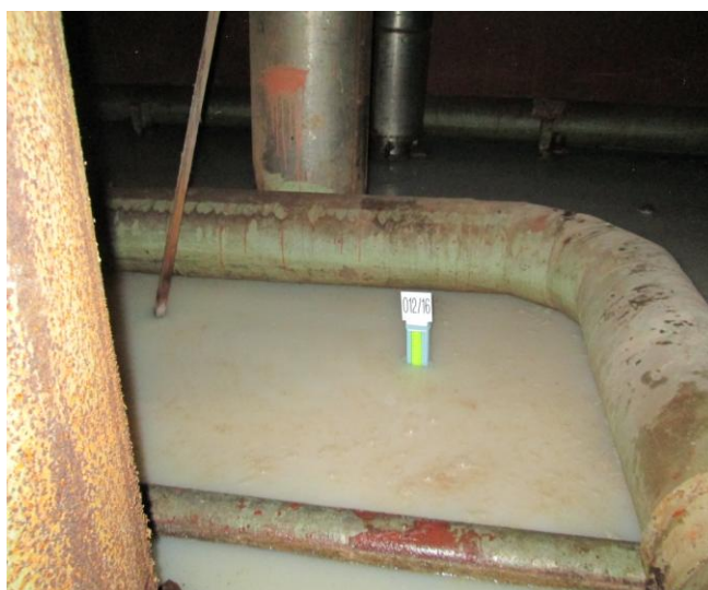
Рис. 4. Водное скопление в южной части помещения 012/16 (т. о. 6).
