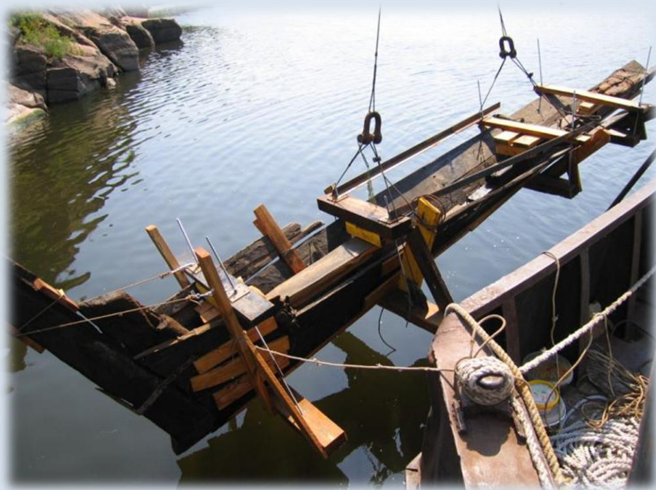
Фото 24. Корма судна в подъемной конструкции.
