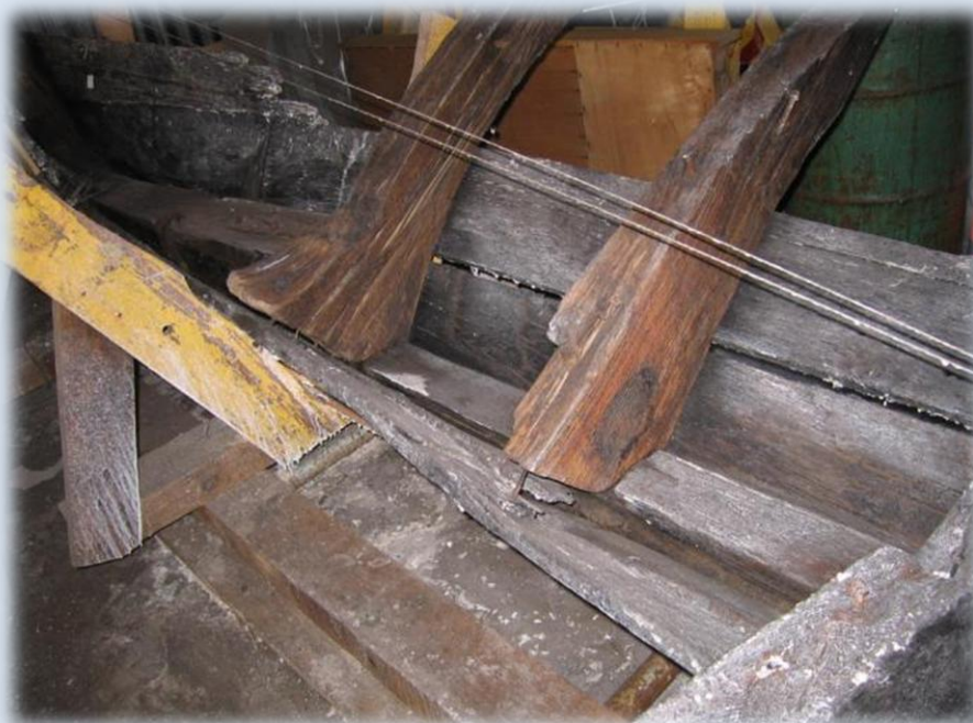
Фото 26. Консервация корпуса судна.
