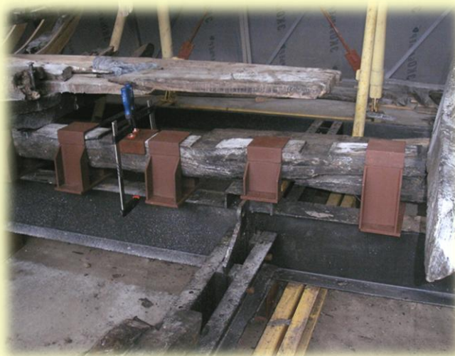
Фото 2. Установка кільових вузлів
