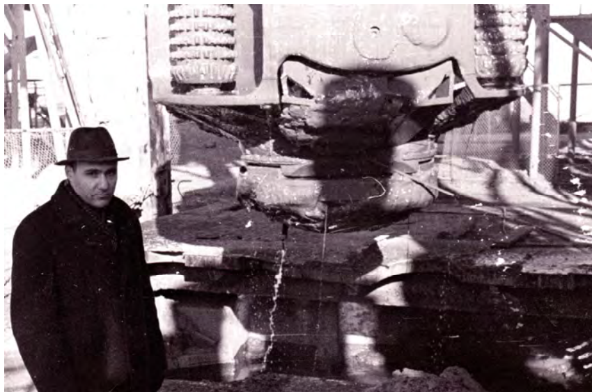
Рис. 4. Внешний вид буровой установки УЗТМ – 7,5 с вращающимися резцами на шаровой опоре
