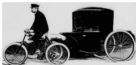
Рис. 7. Трицикл с прицепной пассажирской коляской
