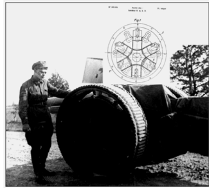
Рис. 7. Испытания французской пушки на колесах с пневматическими ступицами Луцкого в РККА. Фотография из коллекции А. Кириндаса.
