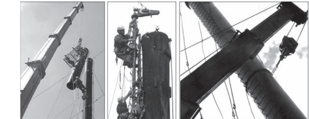
Рис. 10. Последовательность ремонтно-восстановительных работ аварийной металлической дымовой трубы диаметром 0,8 м, высотой 30 м
