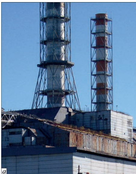
Рис. 14. Старая и новая вентиляционные трубы (а) четвертого реактора ЧАЭС. Капиллярный контроль элементов каркаса новой вентиляционной трубы Чернобыльской АЭС (б)
