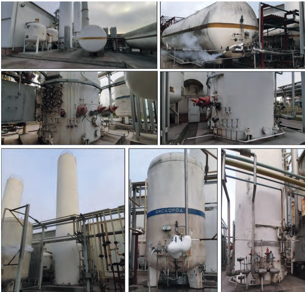
Рис. 1. Посудини тиску станції розподілу повітря
