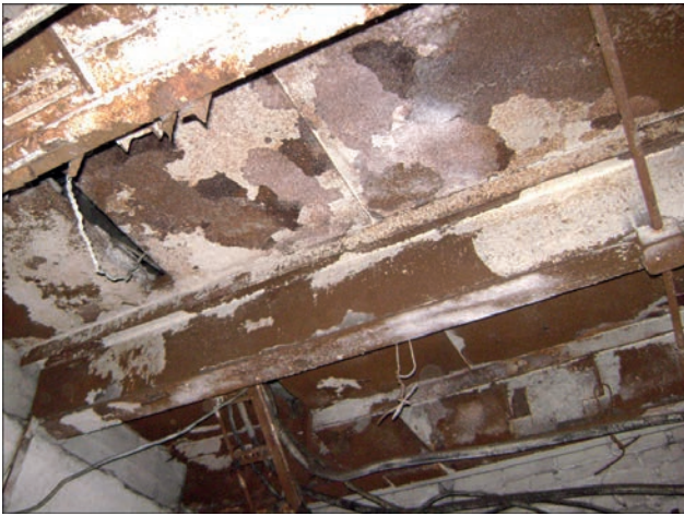
Рис. 2. Корозія металевих листів і балок із двотавра підкопрові рами копра
