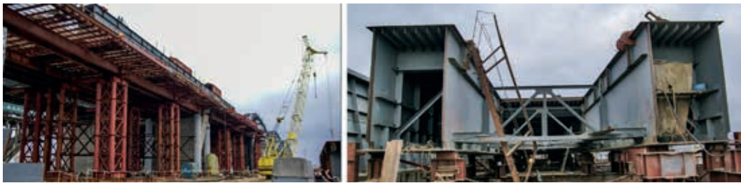
Рис. 2. Будівництво залізнично-автомобільного переходу через р. Дніпро на залізничній ділянці Київ-Московський–Дарниця
