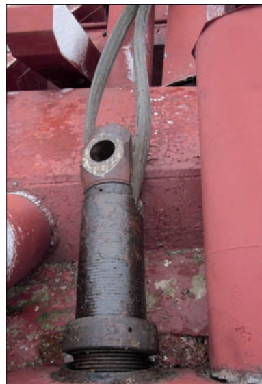
Рис. 1. Закріплення канату
