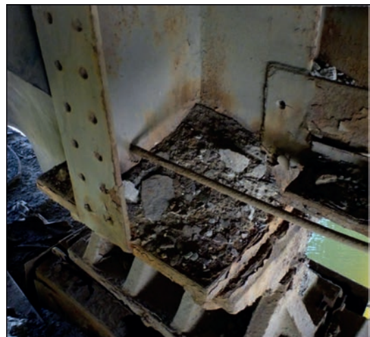
Рис. 7. Приклад скупчення сміття на кінцях прогонових споруд у зоні деформаційного шва
