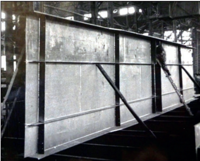
Рис. 2. Приклад збирання ферм головних балок з використанням автоматичного та напівавтоматичного зварювання [1]
