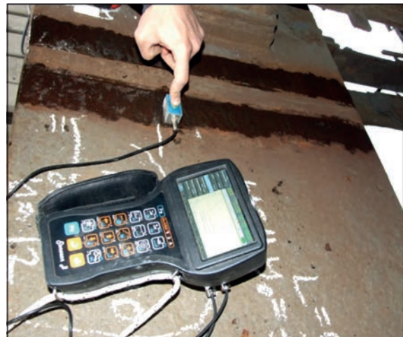
Рис. 4. Контроль стикового шва у верхньому поясі з'єднувальної вставки
