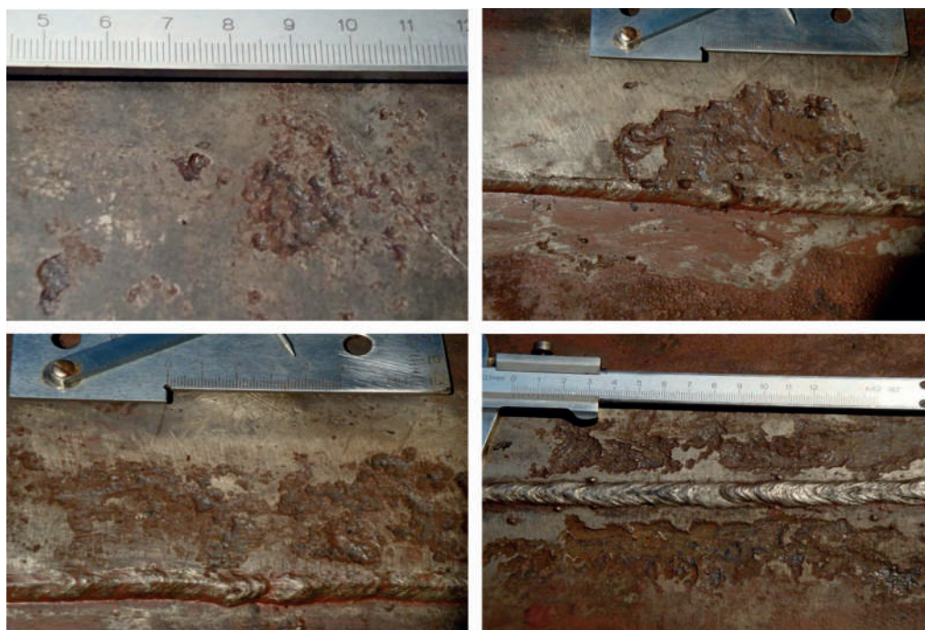
Рис. 3. Загальний вид корозійних пошкоджень днища
