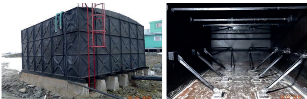
Рис. 2. Резервуар РГС-150. Вид зовні та зсередини
