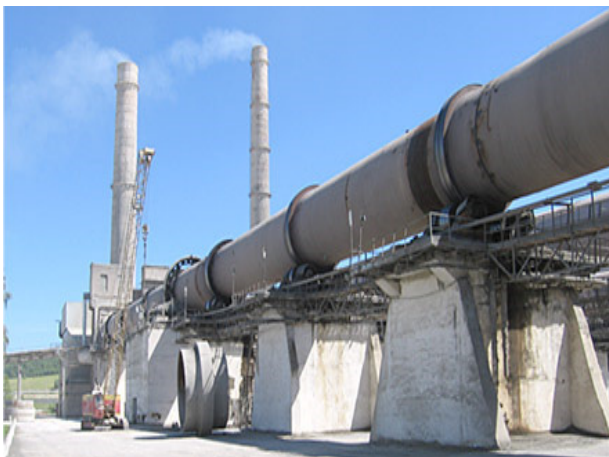
Рис. 1. Зовнішній вигляд цементної печі [8].
