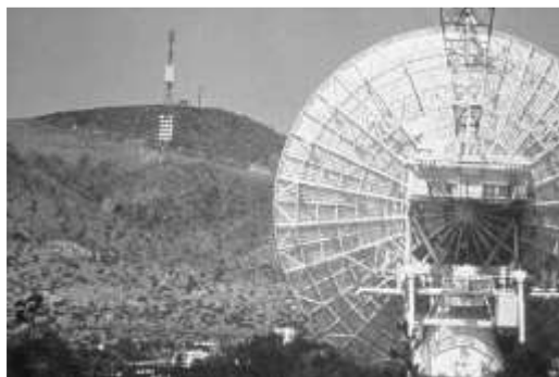
Рис. 1 – Експеримент з бездротової передачі енергії, який був проведений в 1975 році в Голдстоуні (США) [1]
