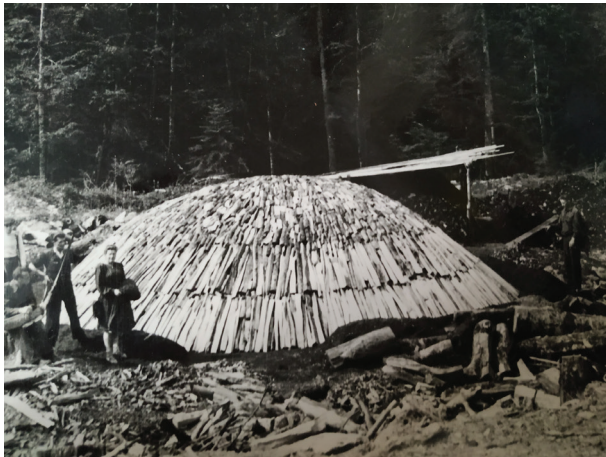
Рис. 1. Суха перегонка деревини бука для одержання вугілля. Ужгородський держлісгосп, 1952 р. Фото Ю.Д. Третяка
