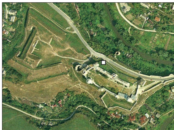
Рис. 1. Місце обвалу стіни
