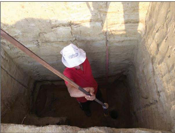
Рис. 3. Меджибізький нижньопалеолітичний мікро-регіон (Хмельницький р-н та обл.), розвідки на палеоліт, 2016 р., шурф 2, геолог С. Кармазиненко досліджує нижню частину шурфу забивним стаканом
