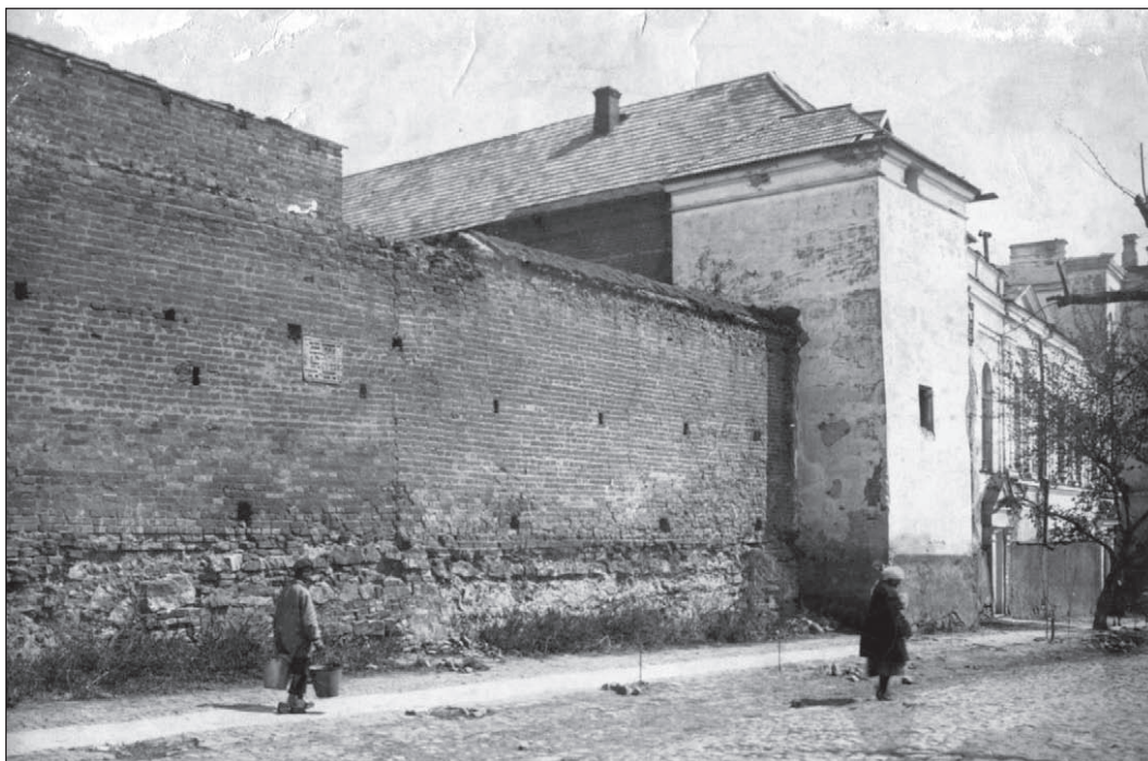
Рис. 2. Наріжна башта постезуїтського господарського флігеля, до якої прибудований мур домініканського комплексу (вигляд із сучасної вул. Монастирської). Світлина 1927 р., з колекції ВОКМ
