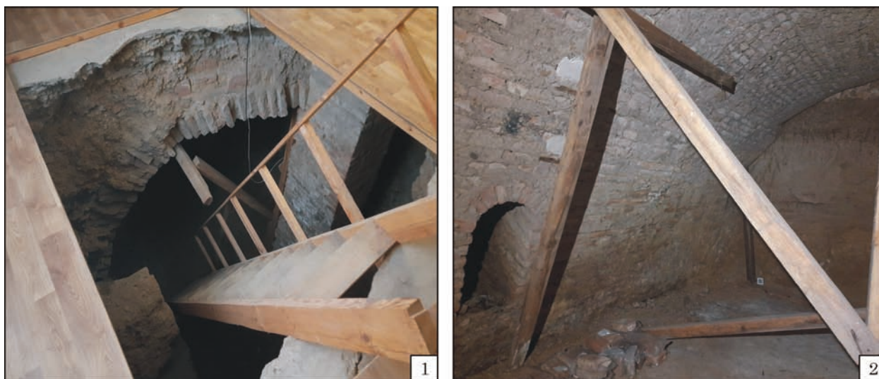
Рис. 2. Мурована підземна споруда (льох) Вінницького обласного краєзнавчого музею, будівля давнього єзуїтського комплексу: 1 — вигляд зверху, місце відкриття; 2 — вигляд всередині приміщення (фото Я. Короленко)
