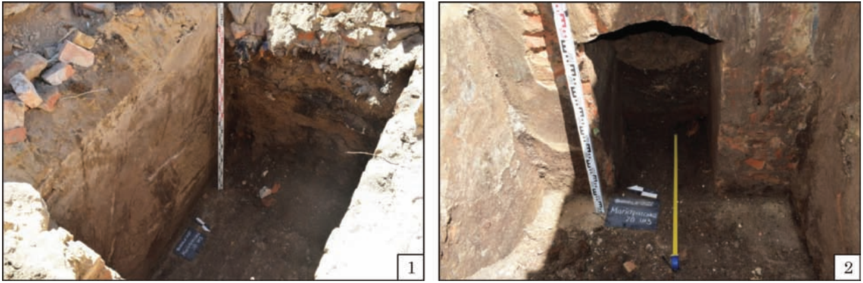
Рис. 14. Частина підвалу на місці демонтованого будинку за адресою Магістратська, 70: 1 — загальний вигляд підвалу; 2 — аркова ніша у південній частині підвалу (за: Корж та ін. 2022)
