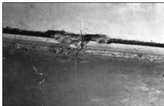
Рис. 5. Вид повреждения стыкового биметаллического шва при испытаниях на усталость крупномасштабной сталеалюминиевой конструкции
