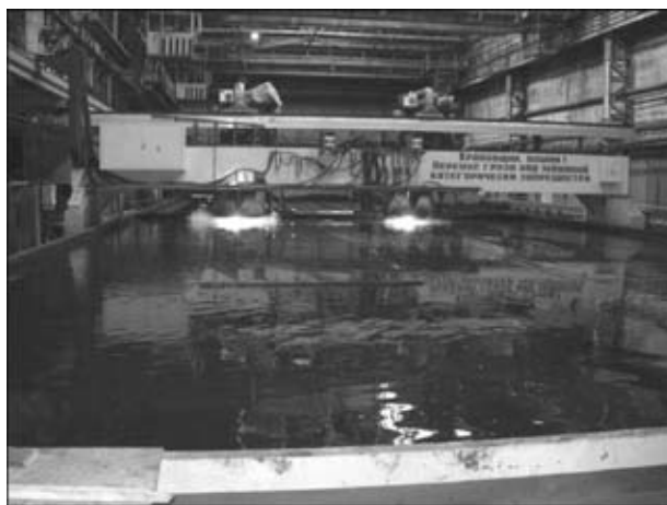
Рис. 1. Установка «Telereх TXB-10200» в работе
