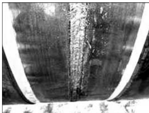
Рис. 1. Вид верхнего слоя шва, выполненного на трубе ручной дуговой сваркой
