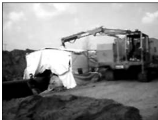
Рис. 2. Монтажная площадка для прокладки трубопровода
