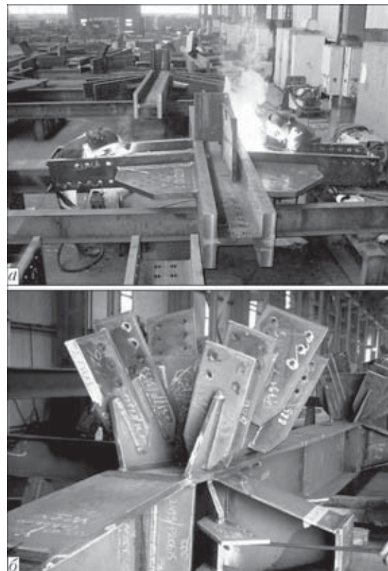
Рис. 8. Сборка сварных узлов конструкций с использованием дуговой сварки плавящимся порошковым электродом в защитных газах на строительной площадке в Гемлике: а — балка с угловой пластиной для Евразийской башни бизнес-центра в Москве; б — балка с угловым листом для стадиона футбольного клуба «Шахтер» в Донецке
