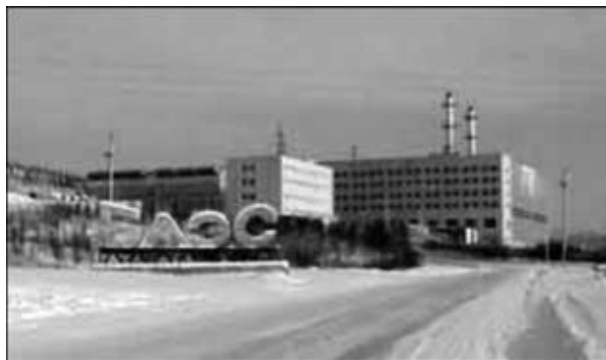
Рис. 4. Внешний вид реактора № 1 Билибинской АЭС [2]
