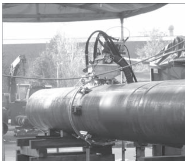
Рис. 3. Сварка труб с помощью установки для испытаний
