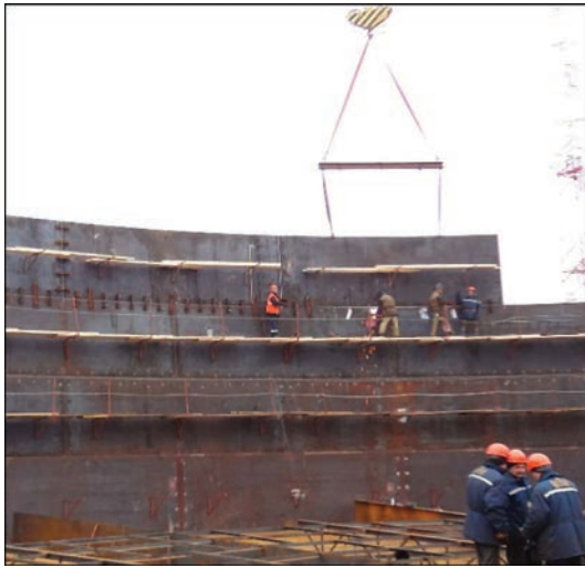
Рис. 5 Монтаж стенки резервуара РВСПК 50 тыс. м 3 с применением листов 2,5×8,0 м
