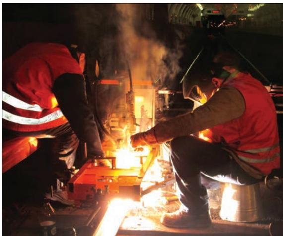
Рис. 2. Автоматическая электродуговая сварка рельсов ваннным способом плавящимся мундштуком в туннеле киевского метрополитена
