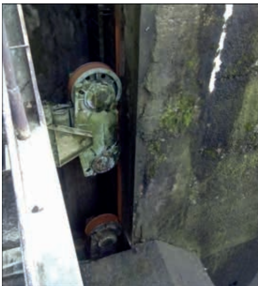
Рис. 3. Опорний візок підйомно-опускних воріт Канівського судноплавного шлюзу
