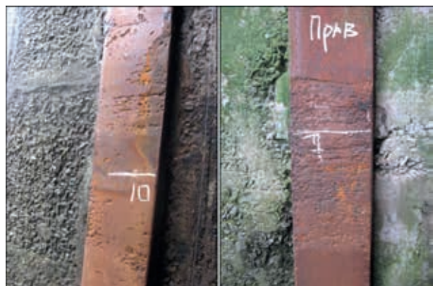
Рис. 5. Характерні пошкодження рейок робочих шляхів підйомно-опускних воріт Канівського судноплавного шлюзу
