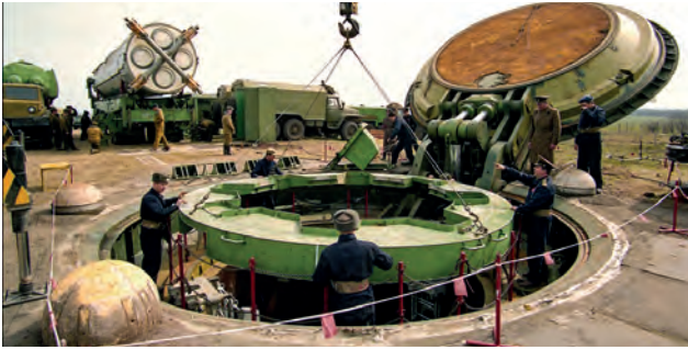
Шахтна пускова установка підготовлена до демонтажу
