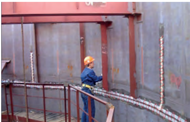
Робочий момент обробки вибухом декомпозера
