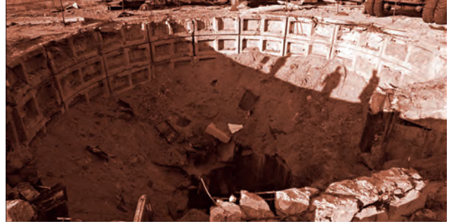
Шахтна пускова установка після утилізації вибухом
